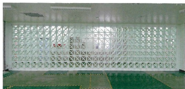
3.UFCブロック組積完了
