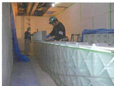
2.UFCブロック組積状況
