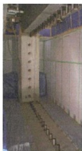
1.鋼管コッター施工完了
