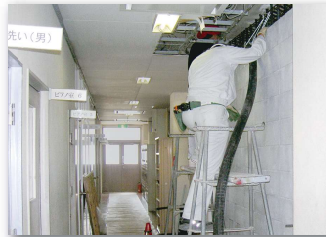
安震ブロック (RM耐震補強工法)
