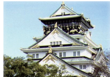
【再アルカリ化工法 施工例】
