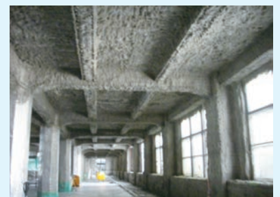
施工例 (建築物内部)
