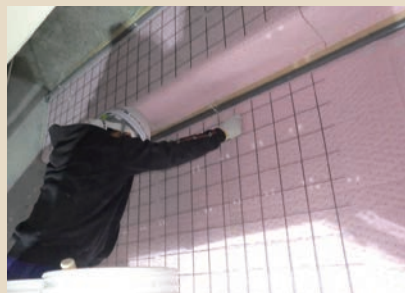
【保水マット・メッシュ設置状況例】
