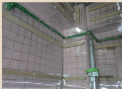
【壁・柱・梁施工例】*通電中
