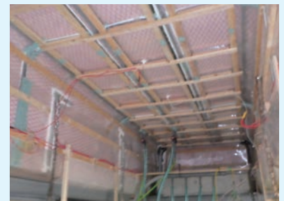
施工例 (橋梁上部工)
