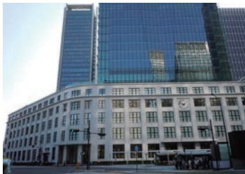
【再アルカリ化工法 施工例】
