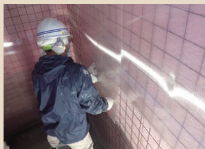
【ポリカーボネート板設置状況例】
