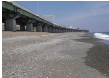
【脱塩工法 施工例】
