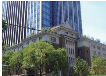
【再アルカリ化工法 施工例】
