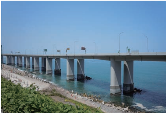
【脱塩工法 施工例】
