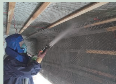
【ファイバー吹付状況例】
