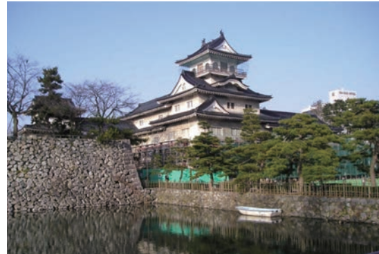
【再アルカリ化工法 施工例】
