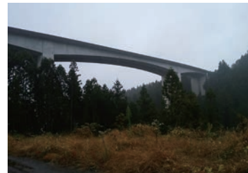
【脱塩工法 施工例】
