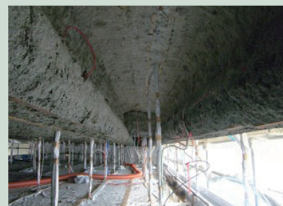
【床版・桁施工例】*通電中
