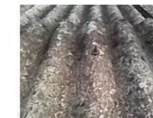
フックボルト周り
