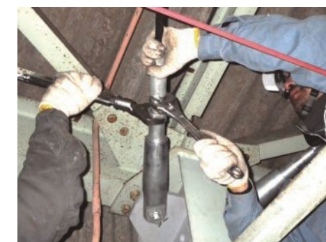
人力でのケーブルへの張力導入作業
