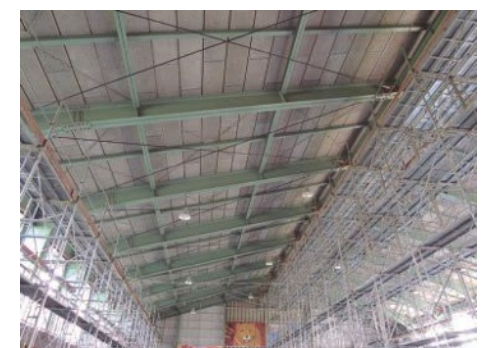
足場の設置状況（屋根、長尺配置）
