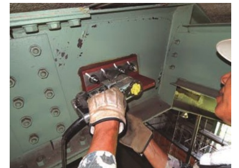
定着金具の取付（屋根）
