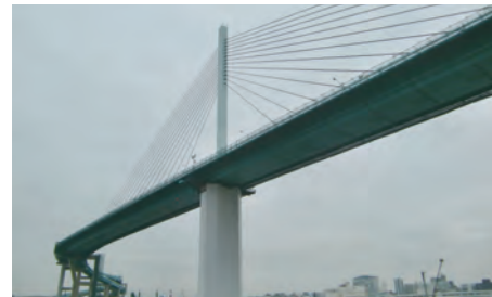
荒津大橋 (福岡県)
