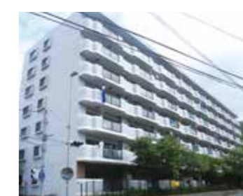
施工後(リアネットE工法)
