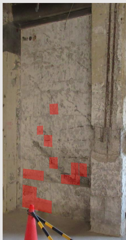
仕上げ後の状況確認
