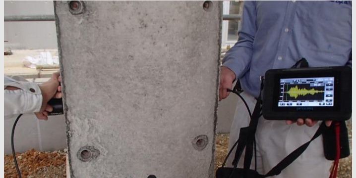
超音波法によるコンクリート内部状態の調査状況
