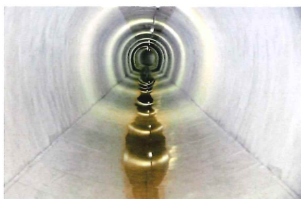
粗度係数の改善・耐摩耗性向上 (導水路トンネル)
