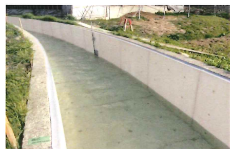
粗度係数の改善・耐摩耗性向上 (農業用水路開渠)
