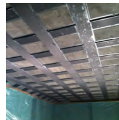
床版下面の補強
