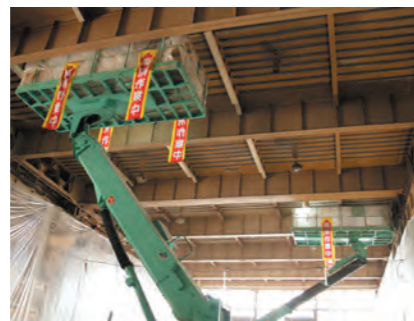
高所の床スラブ補強
