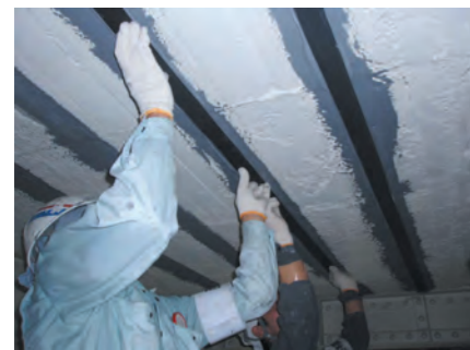
床スラブの補強
