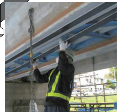
桁の曲げ補強
