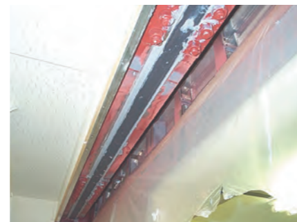
鉄骨梁の補強
