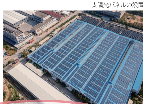
太陽光パネルの設置
