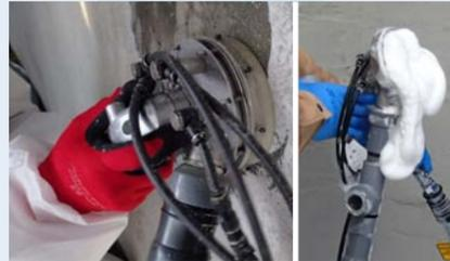
● 泡で発生粉塵の飛散防止と回収処理
