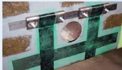
● 施工開孔梁の補強
