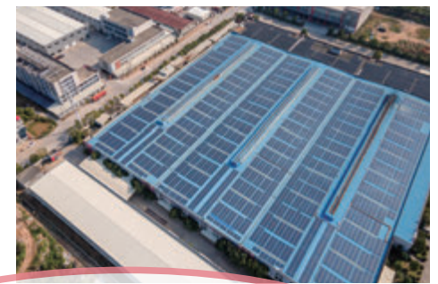
太陽光パネルの設置
