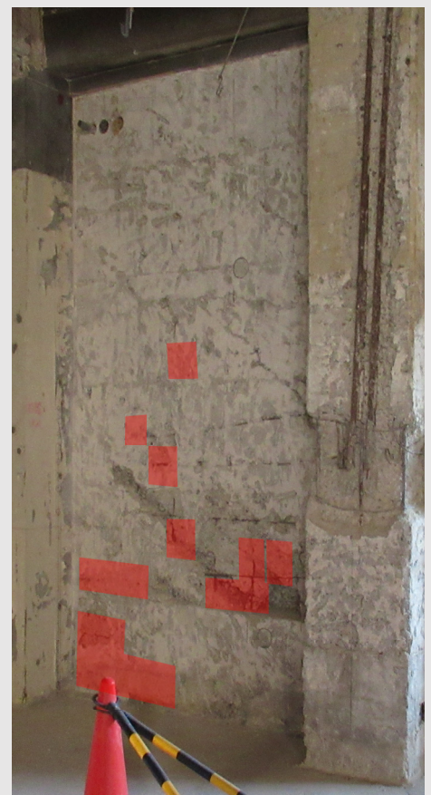
仕上げ取外し後の状況確認
