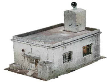
野島埼灯台霧信号舎
