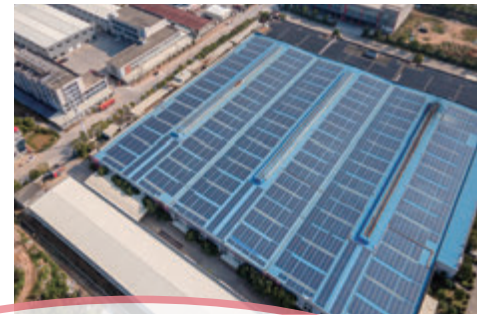
太陽光パネルの設置
