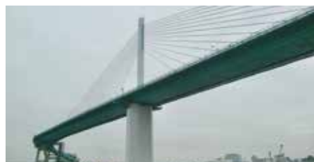
荒津大橋 (福岡県)
