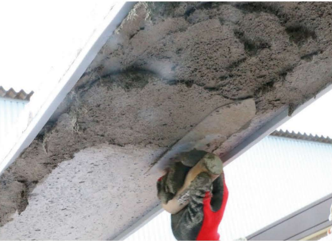
断面修復材施工状況
