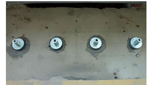
コンクリートを研らずディスクシアキーを配置
