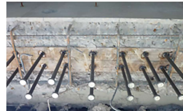
コンクリートを研り内蔵鉄骨にスタッドを溶接
